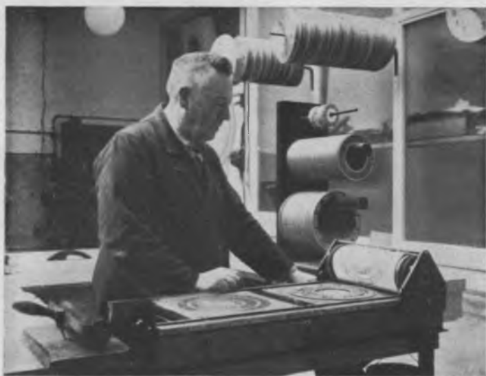
VOOR HET BEDRUKKEN DER RINGEN EN WIJZERPLATEN MOEST EEN SPECIALE DRUKPERS GECONSTRUEERD WORDEN.
