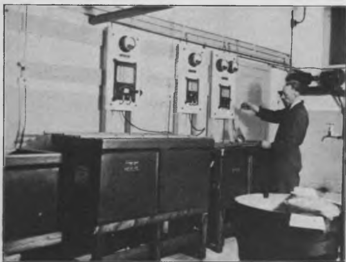
WANNEN SCHAKELBORDEN EN OP DEN ACHTERGROND HET AGGREGAAT.
