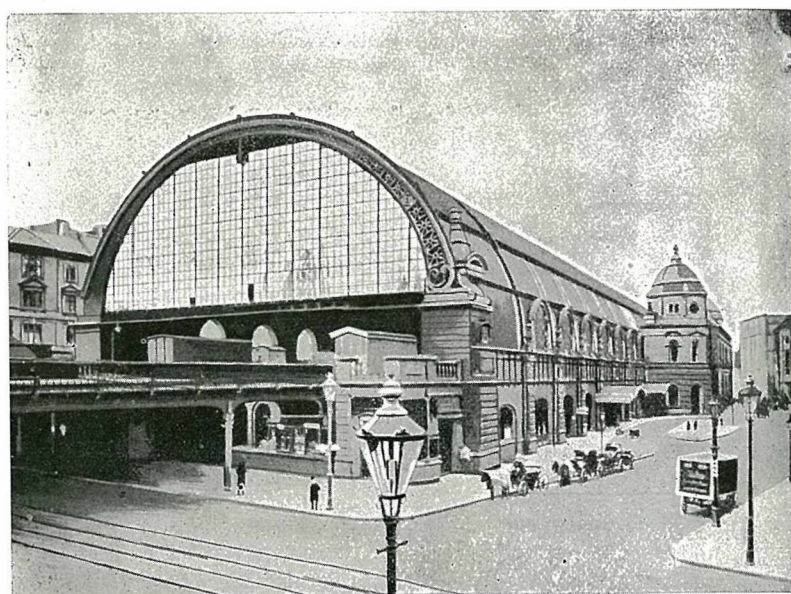
ESTACAO FERROVIARIA ALEXANDREPLATZ — BERLIN Instalação de relógios electricos „Magna“
