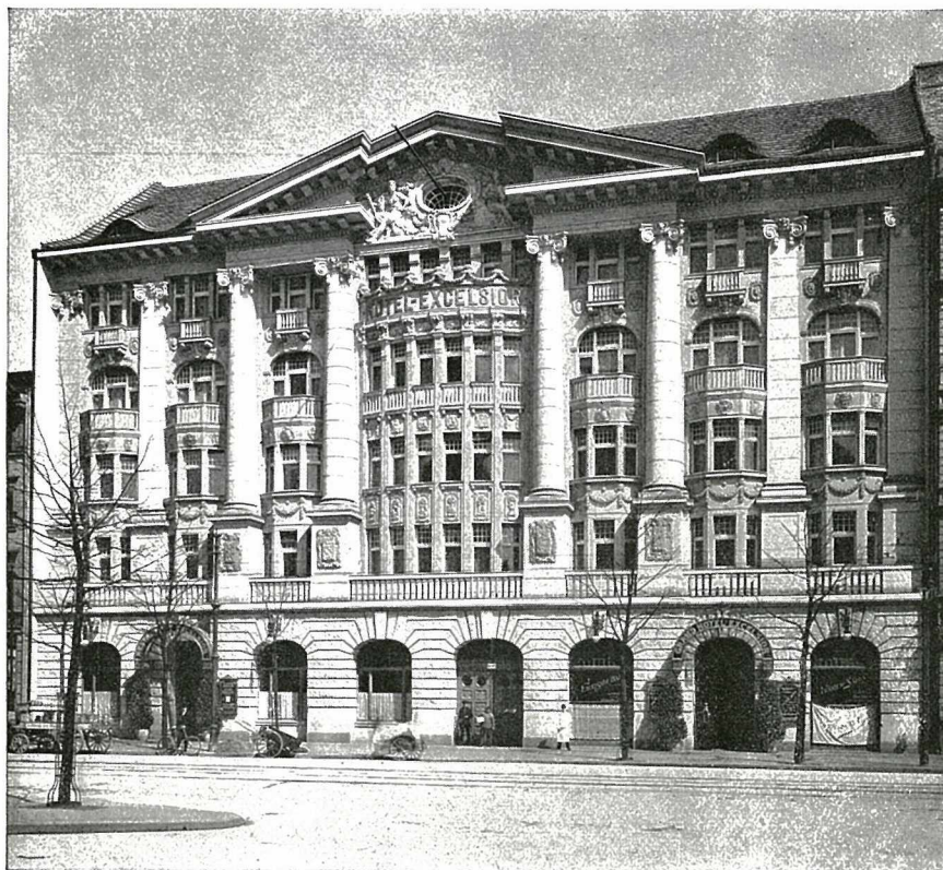
HOTEL EXCELSIOR — BERLIN Instalação de relógios electricos „Magna“
