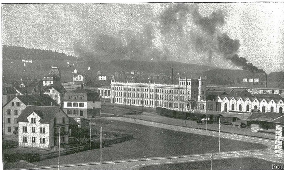
OFFICINAS MECANICAS DE OERLIKON (SUSSIA) Instalação de relógios electricos „Magneta“
