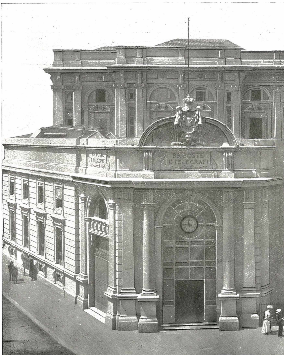
NOVO PALACIO DE CORREIOS E TELEGRAFOS EM MILAO Instalação completa de relógios electricos sistema „Magneta“
