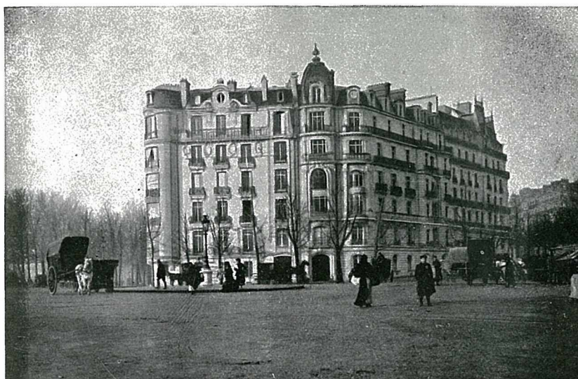
PALACIO DA PRAÇA DE ALMA — PARIS Instalação de relógios electricos „Magna“
