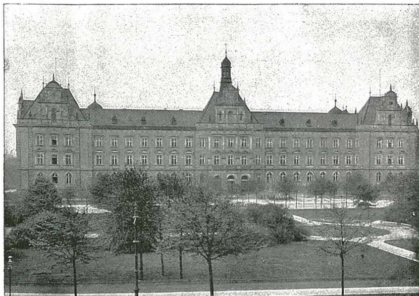
TRIBUNAL CIVIL — HAMBOURGO Instalação de relogios electricos „Magna“
