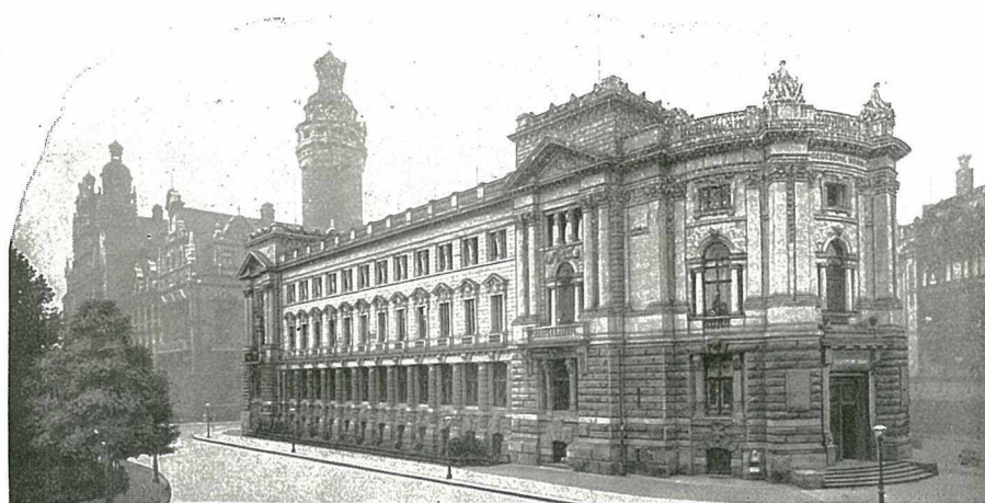
PALACIO DO BANCO ALEMAO — DRESDEN Instalação de relógios electricos „Magneta“
