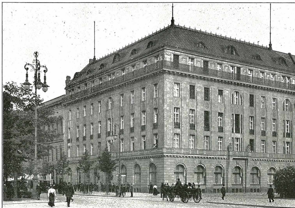
HOTEL ADLON — BERLIN (Installé avec des horloges „Magneta“)
