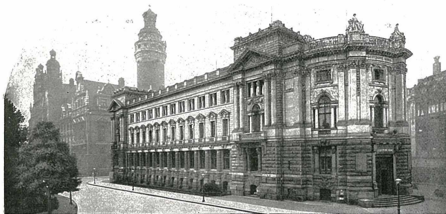
PALAIS de la „DEUTSCHE BANK“ à DRESDE (Installé avec des horloges „Magneta“)
