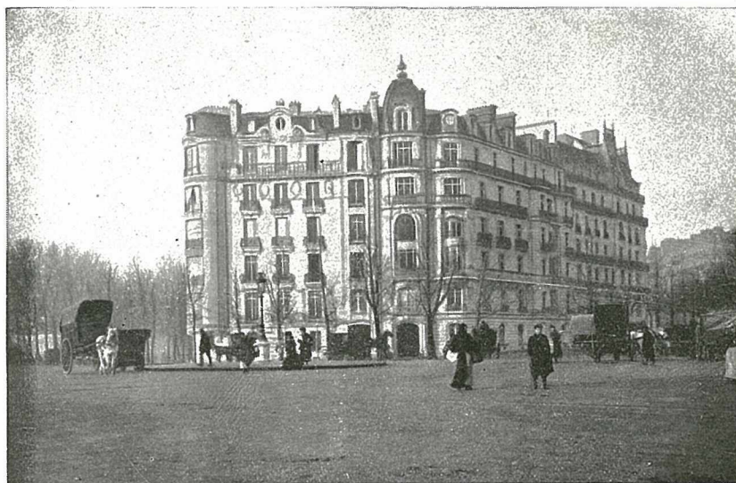
(IMMEUBLE,) PLACE de l'ALMA — PARIS (Installé avec des horloges „Magneta“)
