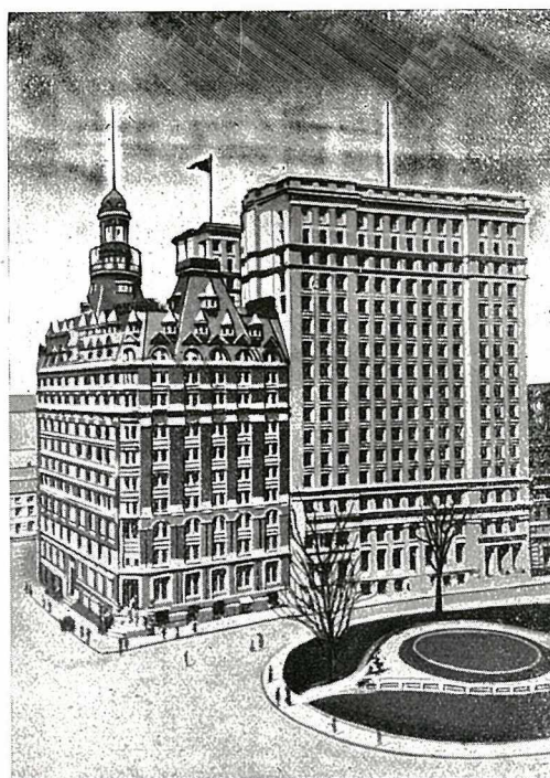
BOWLING GREEN BUILDING — NEW-YORK (Installé avec des horloges „Magneta“)
