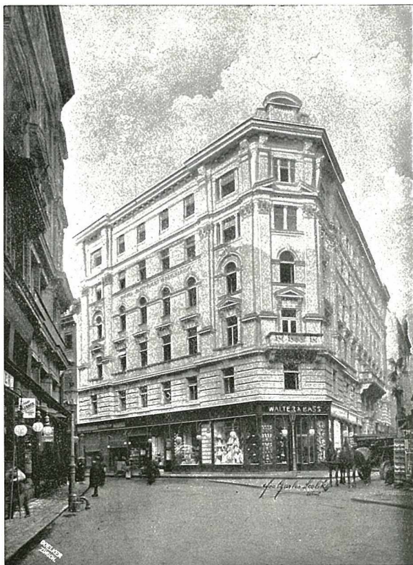
PALAIS de la COMPAGNIE D'ASSURANCE CONTRE LES ACCIDENTS à VIENNE (Installé avec des horloges „Magneta“)
