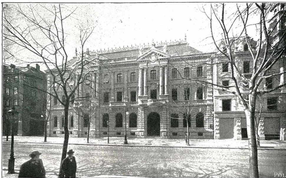
BANQUE CANTONALE à ZURICH (Installé avec des horloges „Magneta“)
