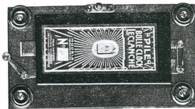
Fig. 17. Gezicht op een batterij met "oortjes" (zonder draden), Model He2, geplaatst in het benedendeel van een klokkast.
